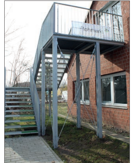
Über die neue Außentreppe geht es zu den neuen Räumlichkeiten des Flohmarktes.
