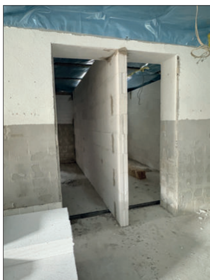
Zurzeit werden die Mauern zwischen den einzelnen Hunderäumen wieder hochgezogen.
