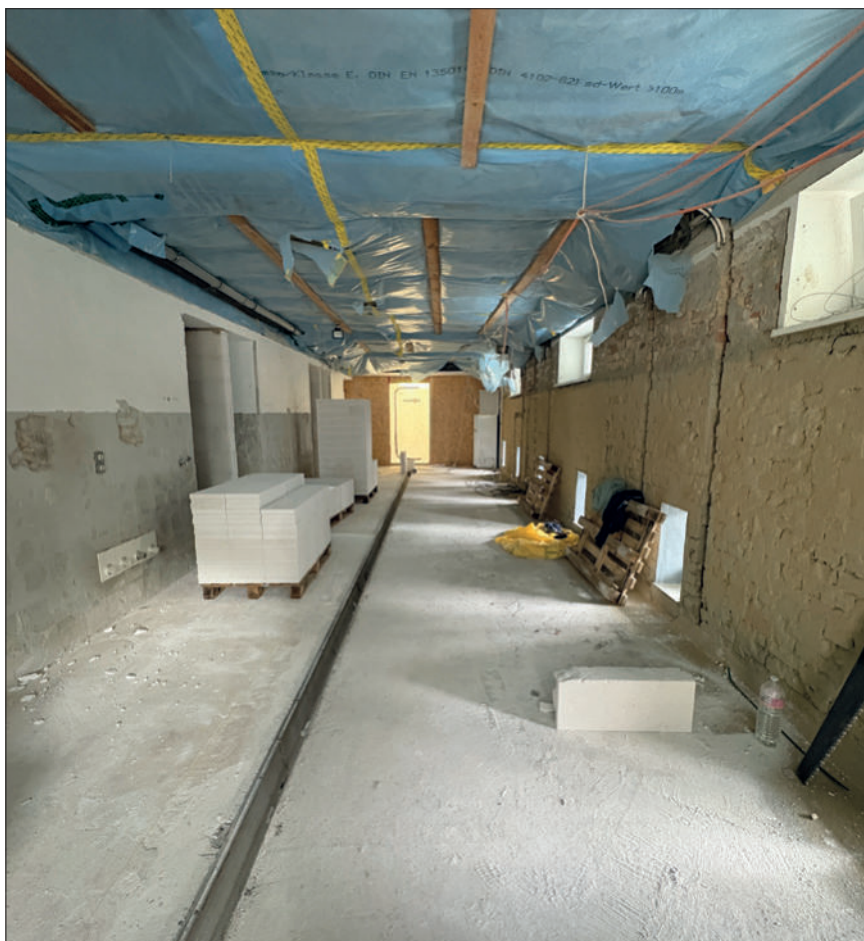
Das Hundehaus musste im Innenbereich komplett entkernt werden.
